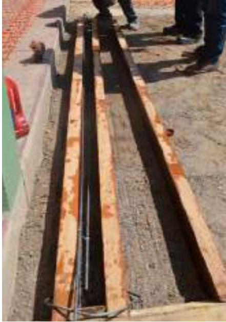
Armado de moldes para viguetas
